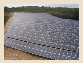
Il 15 settembre abbiamo ultimato gli impianti del campo fotovoltaico da 1Mwp presso il Comune di Castelmuovo Belbo. Si tratta di un'impianto per la produzione e vendita di energia, composto da 4500 moduli fotovoltaici ENI POWER, montanti su strutture metalliche assemblate su pali in acciaio zincato infissi nel terreno.
